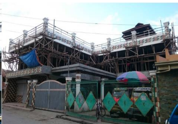
本宅と道路を挟んで向かいにあるビジネスビル建設中
