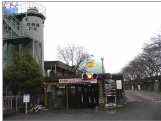
奥の球形が消化ガスタンク 手前の信号は地下通路の東施設出口
