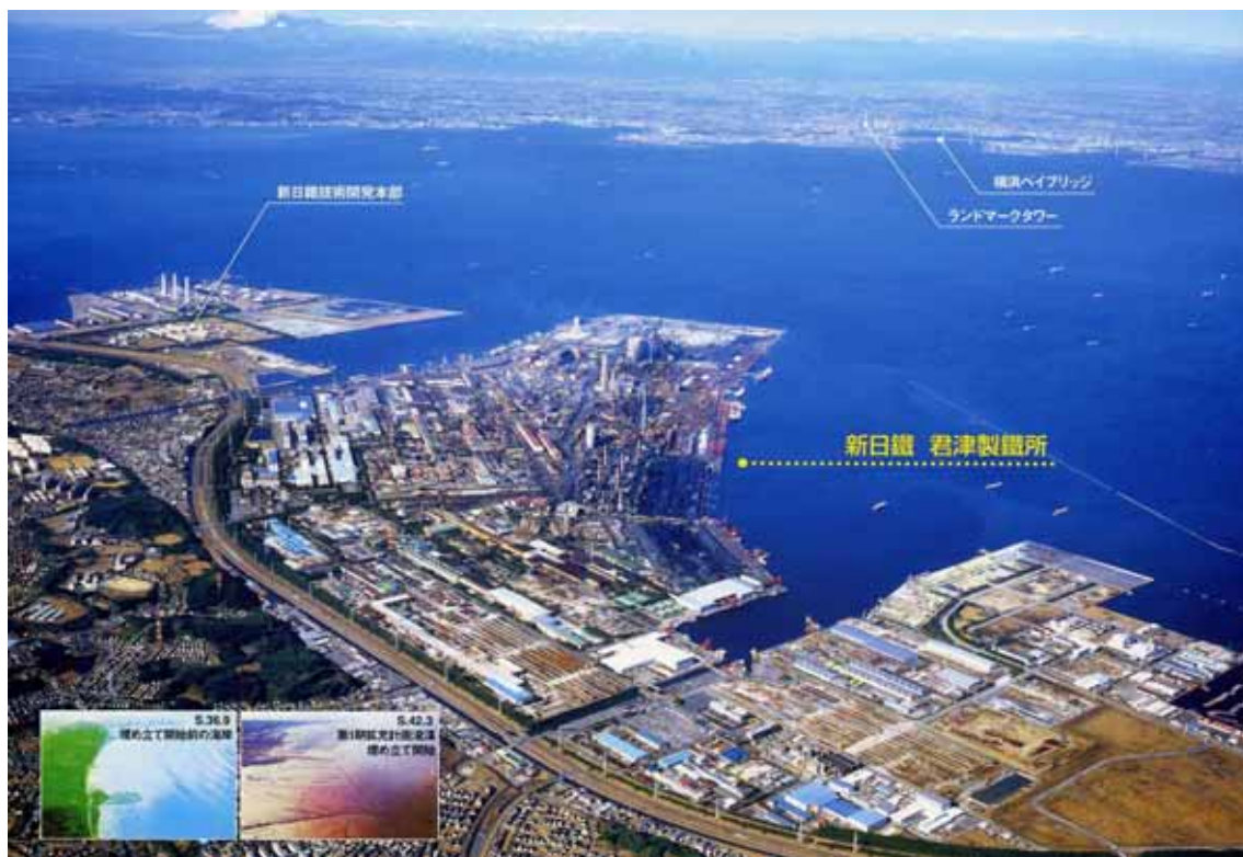
新日本製鐵君津製鐵所全体写真と位置図（以下君津製鐵所のパンフレットから）
