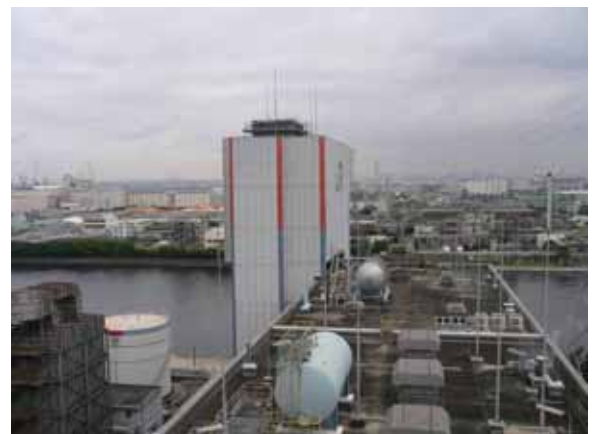
3号棟屋上からみた2号棟建屋
