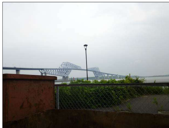
工場のすぐ隣がゲートブリッジ
