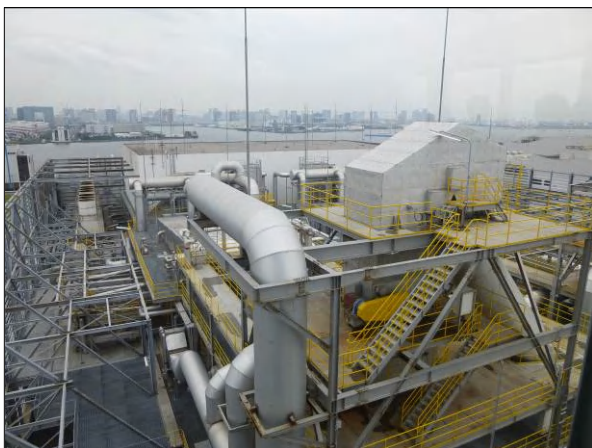
屋上から見た焼却施設
