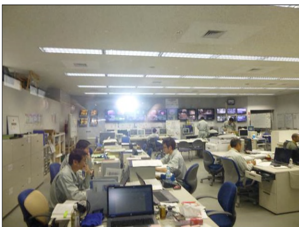
建屋内の管理センターの内部
