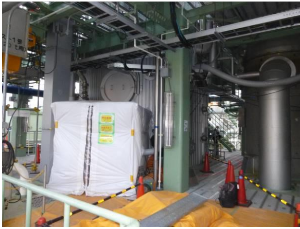
ターボ型流動焼却炉（定期補修工事中）
