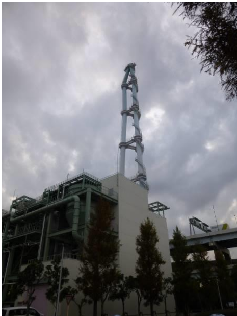
ターボ型流動焼却炉（定期補修工事中）
